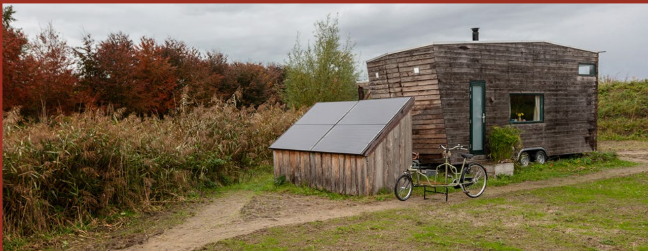
> De 4 zonnepanelen zijn op het schuurtje gemonteerd.
