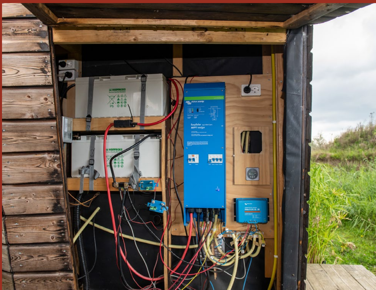
> Het Victron Energy EasySolar-systeem van Noortje en Jan-Willem zit aan de achterzijde van hun tiny house .
